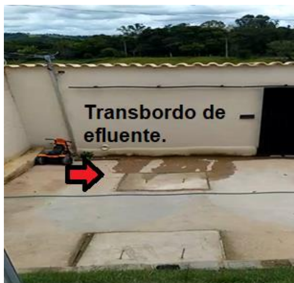
Figura 1: Transbordo de efluente proveniente do sumidouro observado no local. Fonte: Os autores (2020).
